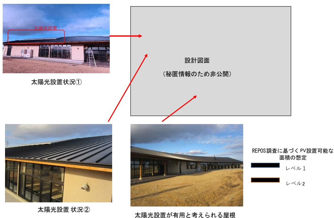
図 5.5-1 みちのく潮風トレイル名取トレイルセンターの太陽光設置状況及び有用と考えられる屋根の状況
