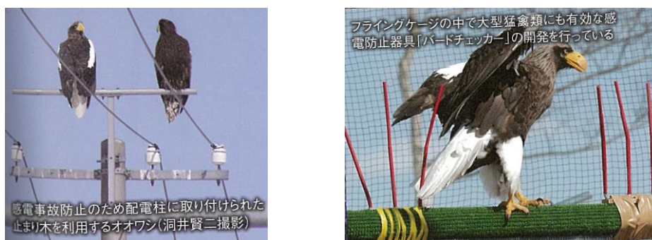
図 8-68 大型猛禽類の感電防止対策例 (左：止まり木、右：バードチェッカー、「野生の猛禽を診る (北海道新聞社)」(齊藤慶輔, 2014) より転載 ※注 )
