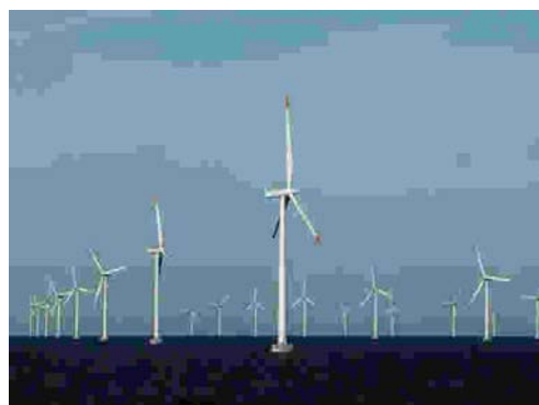
図 2-5 洋上風力発電稼働事例
