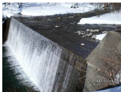
写真 7-14 湯檜曾公園砂防えん堤
